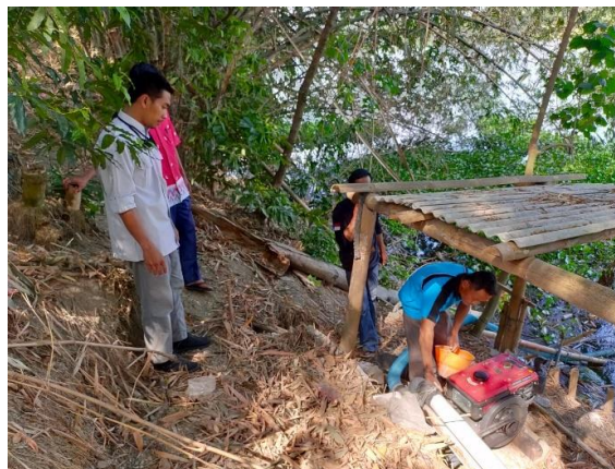
Gambar 4. Pengecekan Sumber Air dan Pemasangan Pompa di Tepi Bendungan
