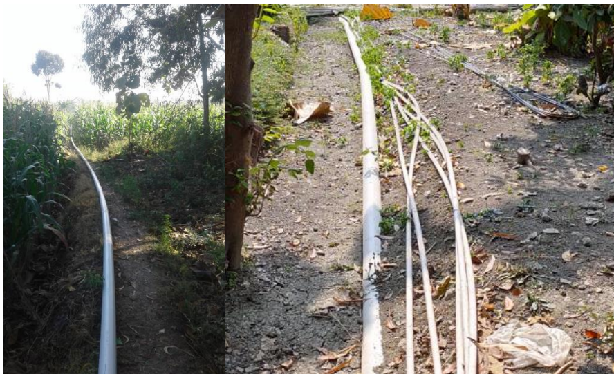
Gambar 6. Pipa Dipasang Melintasi Pemukiman Penduduk dan Galangan Lahan Pertanian
