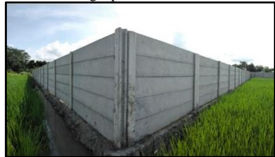
Gambar 1 Pagar Panel Beton dilapangan Sumber : Dokumentasi, 2024
