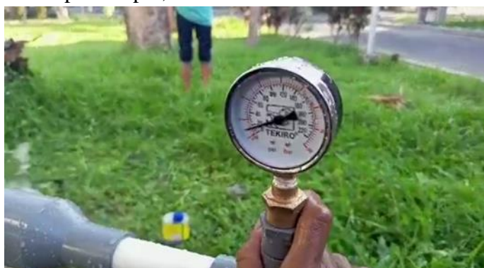
Gambar 8 Pemasangan pressure gauge pada keluaran pompa
